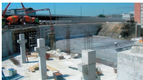
Lavori presso la centrale Tronchetto (fonte: www.veneziatoday.it )
