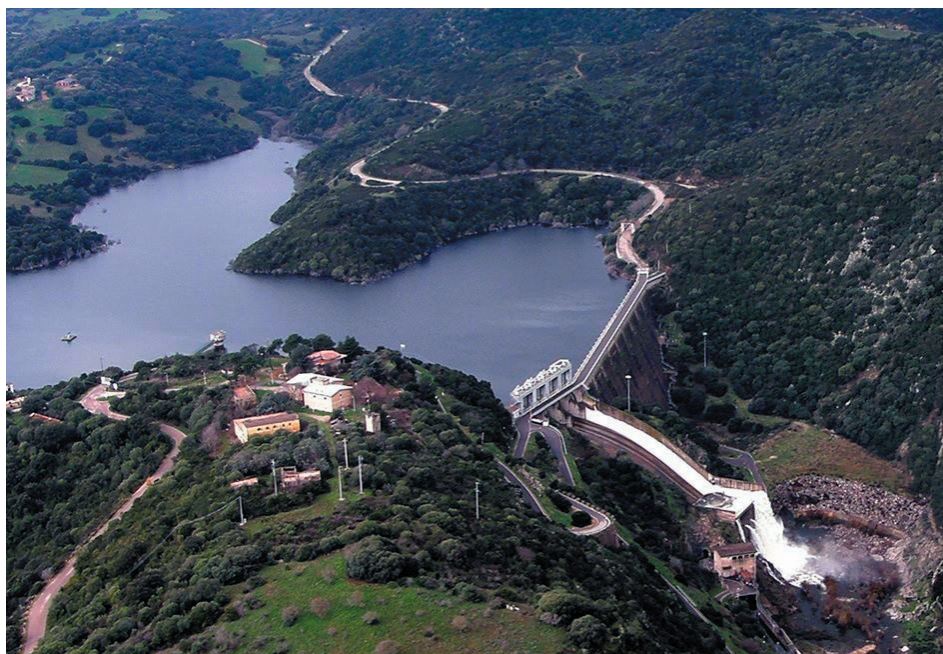
Diga del Liscia (Fonte: www.santantoniodigalluraturismo.it )
