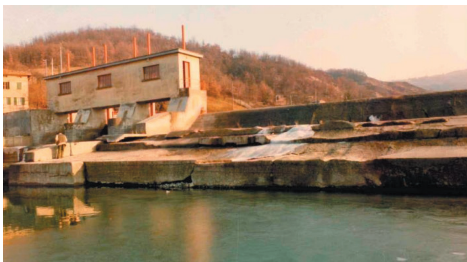
Traversa sul torrente Enza: Stato di fatto (Fonte: documentazione progettuale)
