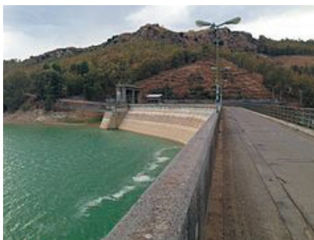
Diga Pozzillo (Fonte: Wikipedia)
