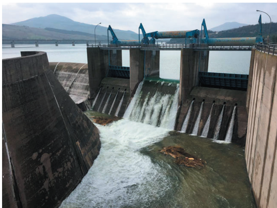
Diga Ponte Liscione (Fonte: molisenews.it)
