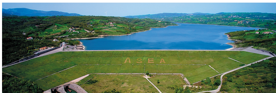
Diga di Campolattaro (Fonte: documentazione progettuale)
