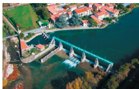
Vista aerea della traversa
