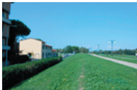
Argine del Fiume Arno lungo via dell'Isolotto. (Fonte: Publiacqua)
