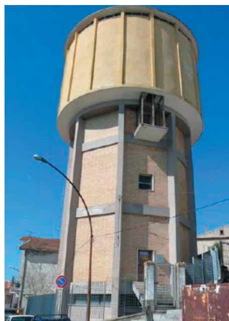
Manufatto in San Martino in Pensilis. (Fonte: documento preliminare alla progettazione)
