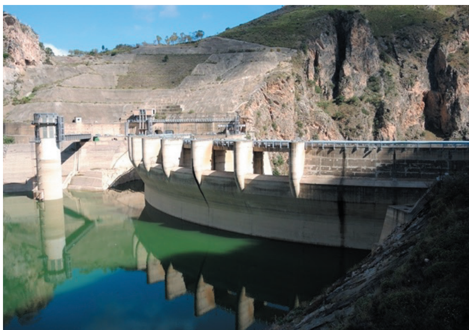
Diga Rosamarina (Fonte: sito web della DG Dighe del MIMS)
