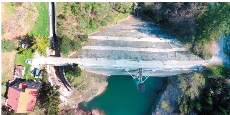
Diga Cerventosa (Fonte: relazione tecnica)
