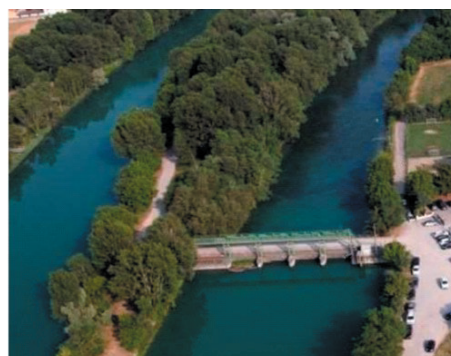
Diga di Salionze (Fonte: documentazione progettuale)
