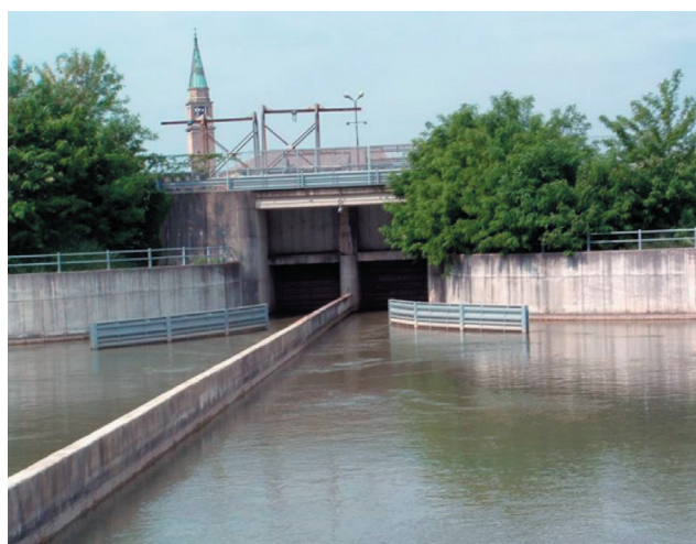
Opera di presa del condotto Guà-Bacchiglione presso Cologna Veneta (Fonte: Consorzio di bonifica di Il grado Lessinia - Euganeo - Berico)
