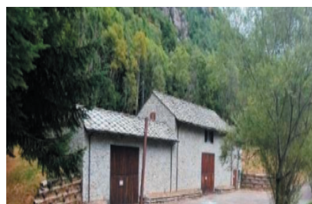
Manufatto realizzato con tecnica di ingegneria naturalistica.
