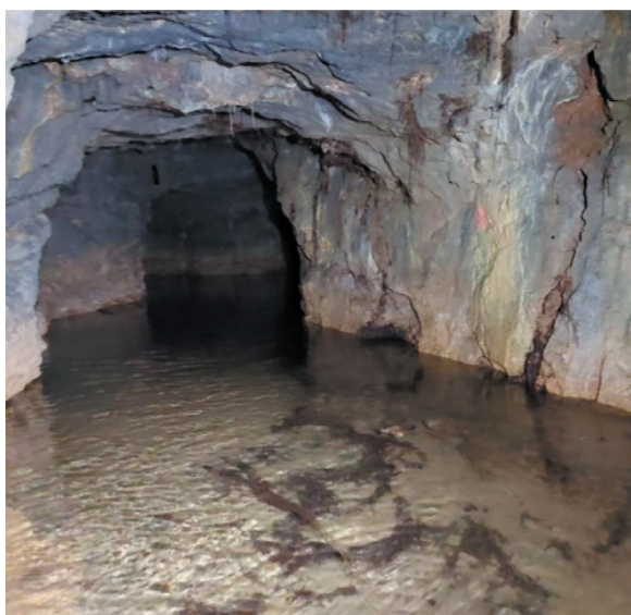
Galleria sorgente Mazzoccolo, imbocco sud (Fonte: relazione geologica al progetto definitivo)
